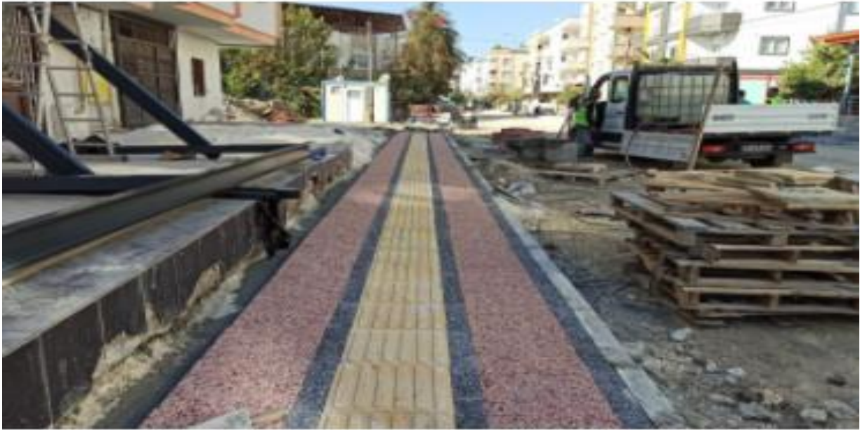
MERSİN BÜYÜKŞEHİR'DEN TARSUS'A 4 MAHALLEDE YOL YAPIM VE BAKIM ÇALIŞMASI
